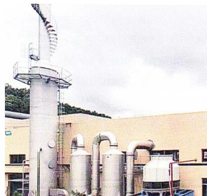
Жидкость в колонне скруббера поглощает и забирает загрязняющие вещества из пара. Очистка пара осуществляется путем химической реакции с жидкостями: кислотой, окислителем и щелочью.
